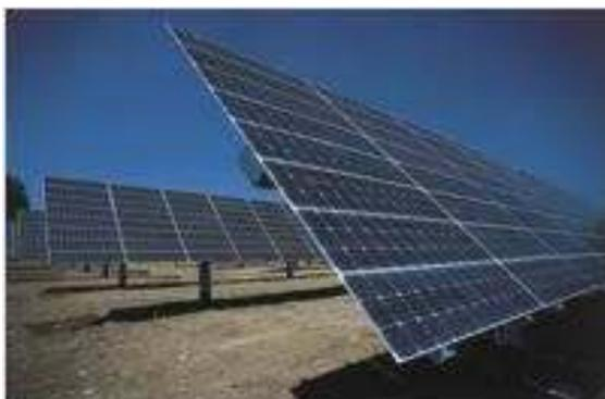
**Solaranlage:** Die [Photovoltaik-Anlage auf dem Mont-Soleil](#) ist die grösste Forschungs- und Demonstrationsanlage dieser Art in der Schweiz. Sie zeigt die Möglichkeiten und Grenzen der Solarnutzung auf. Auf 20 000 m<sup>2</sup>, was einer Grösse von drei Fussballstadien entspricht, wandeln Silizium-Solarzellen das Sonnenlicht direkt in elektrischen Strom um.
